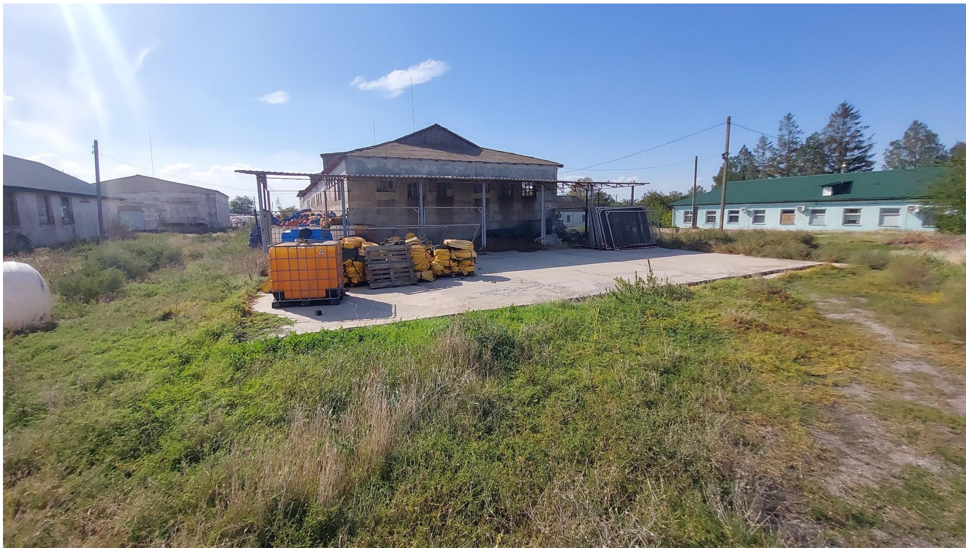
Фото 83. Навес с площадкой, расположенные за складом МРС №-003, -004, -007, -016, -019
