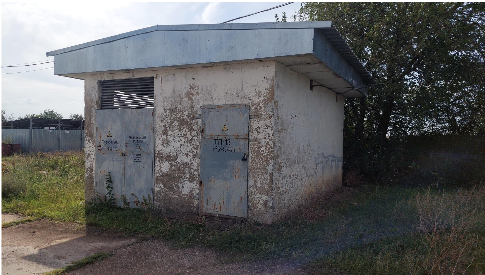
Фото 9. Здание одноэтажное – ТП-13 РУ-0,4кВ
